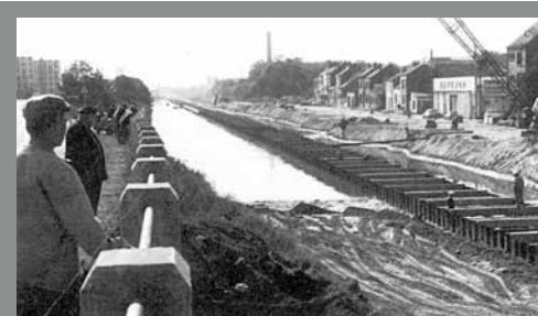
La pénétrante Est prend place dans le lit du canal de Mardyck
