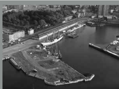
Le pertuis de la Marine, site du futur Hôtel Communautaire
