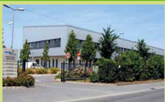
Centre Technique Communautaire (CTC) Rue Vancauwenberghe - Dunkerque 18 Arrêt "Triselec"
