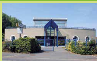
Poste Central de Trafic Rue de l'Abattoir - Dunkerque C5 Arrêt "Ecoparc"
