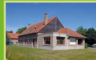
Atelier du lac Rue du Lac - Armbouts-Cappel 19 Arrêt "Le Lac"
