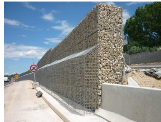
Ecrans en gabions
