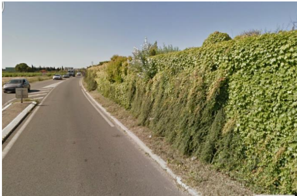
Ecrans végétalisés avec mur béton
