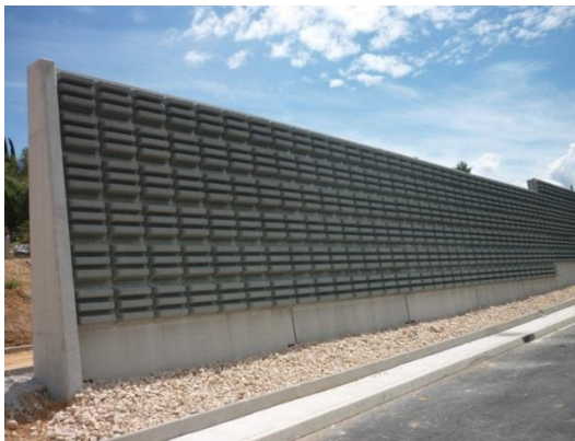
Ecrans en béton bois
