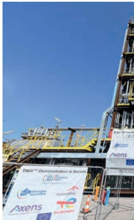
gaz issus de la production d'acier. Les fumées passent dans des colonnes où un solvant en sépare le dioxyde de carbone, récupéré pour être envoyé dans des sites de stockage souterrains en mer du Nord. Combiné à de l'hydrogène, il peut aussi servir à fabriquer des carburants de synthèse pour le transport maritime et aérien, comme le prévoit le projet Reuze qui sera développé à Dunkerque.
