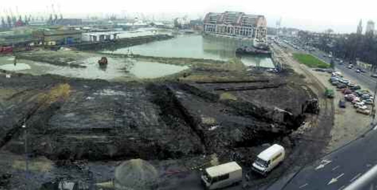
→ Travaux préparatoires à la construction du Centre Marine.
