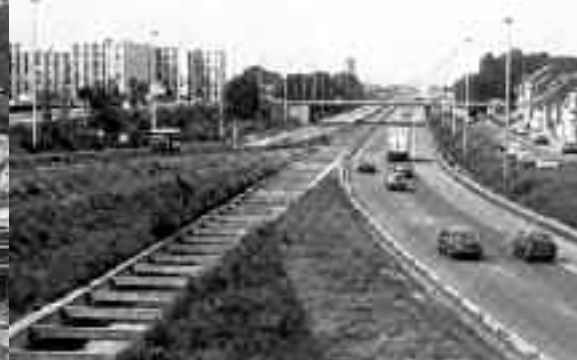
→ La pénétrante Est prend place dans le lit du canal de Mardyck.
