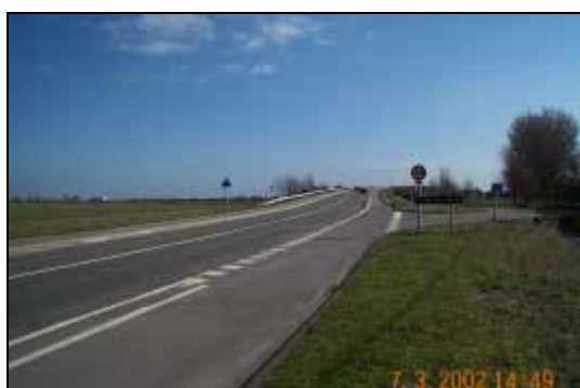
sortie d'agglomération-passage A16
