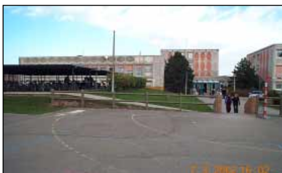
Parking vélo à l'intérieur de l'établissement
